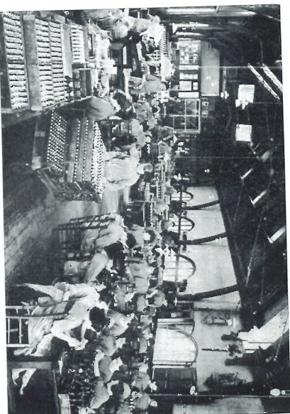
De flessen worden geheel automatisch gevuld en gekurkt. Nijvere meesters drukken de rode lakstempels er op.
